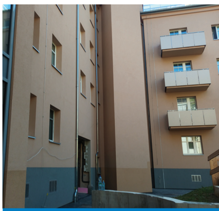
IPA Haus – Hof saniert
